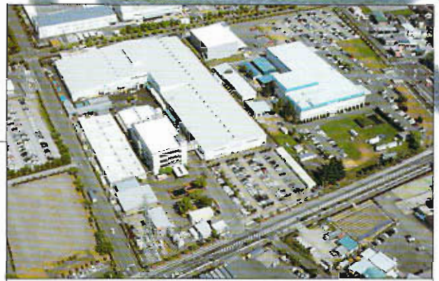
ЗАВОД В КОФУ (Площадь: 543 905 кв. футов Общая площадь зданий: 260 638 кв. футов)
