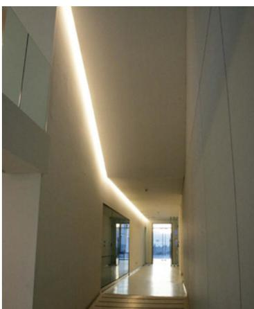
Linear Flex HP 72W es una luminaria muy adecuada para la iluminación de cornisas y foseados que proporciona luz indirecta y de alto rendimiento lumínico.
